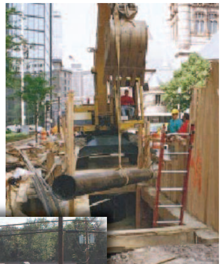
Separación del alcantarillado
